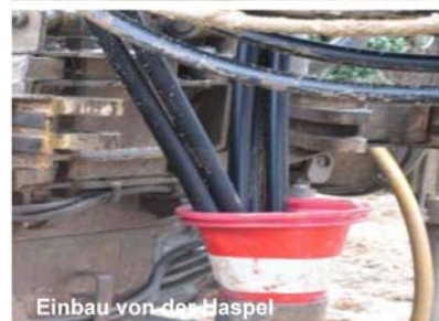
Auf einer Haspel; ab Werk angeschweißter Sondenfuß sichtbar
