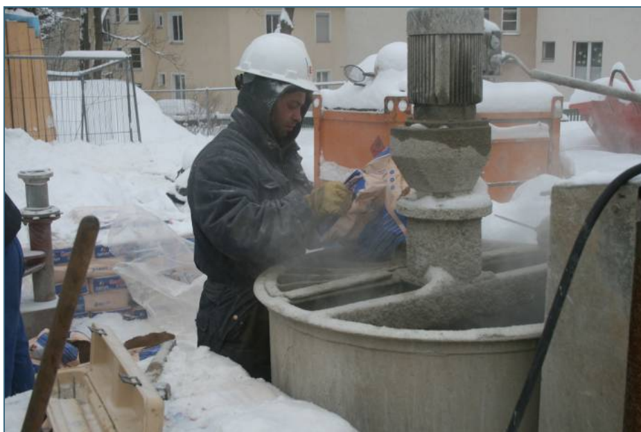
Abb. 11: Herstellung der Suspension auf der Baustelle mit Sackware (Fertigprodukt) (Quelle: LfU)
