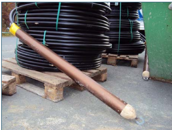
Abb. 7: Auf die Baustelle ange- lieferte Sondenbündel werden werkseitig auf- gerollt und auf die vor- gesehene Länge mit Sondenfuß und Öse zur Befestigung eines Zuggewichts gefertigt. (Quelle: LfU)
